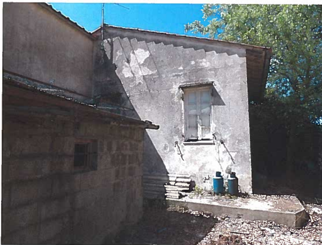
Vista dal resede di proprietà- dal Lato Est
