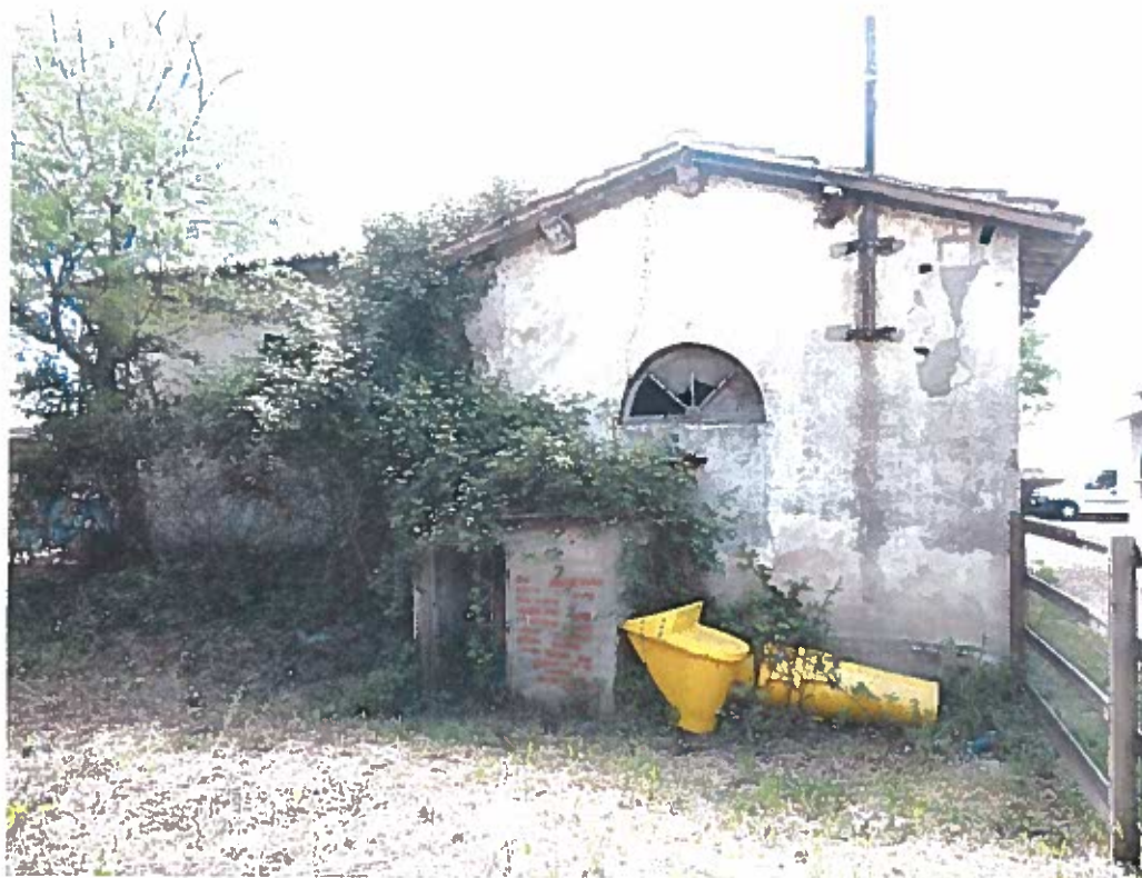
Vista dal resede di proprietà- dal Lato Nord
