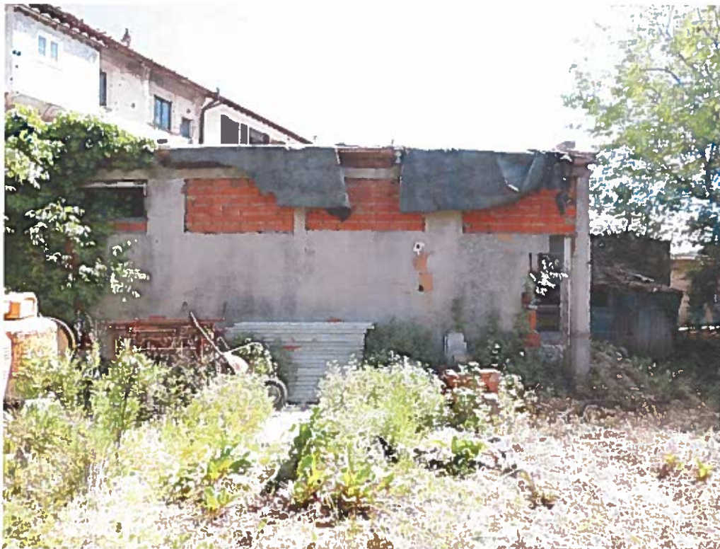
Vista dal resede di proprietà-dal Lato Ovest
