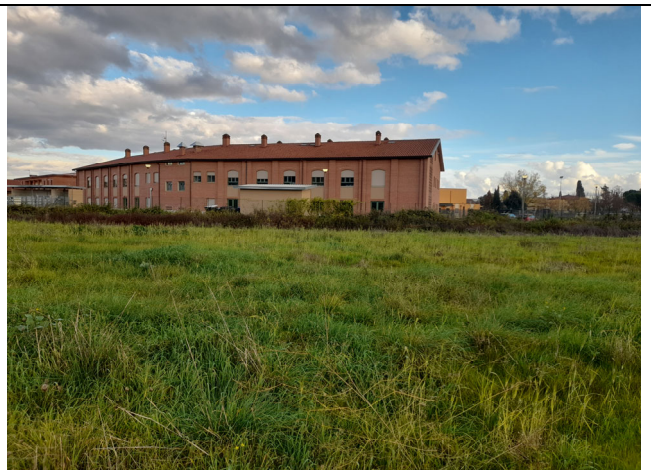
Foto 4 – Particolare vista est – struttura sanitaria
