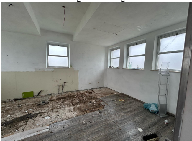
P.T. Locale negozio dx angolo Nord Est
